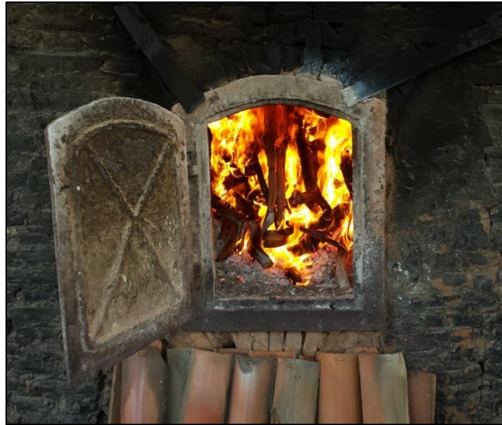
Figura 62 – Câmara de combustão.
