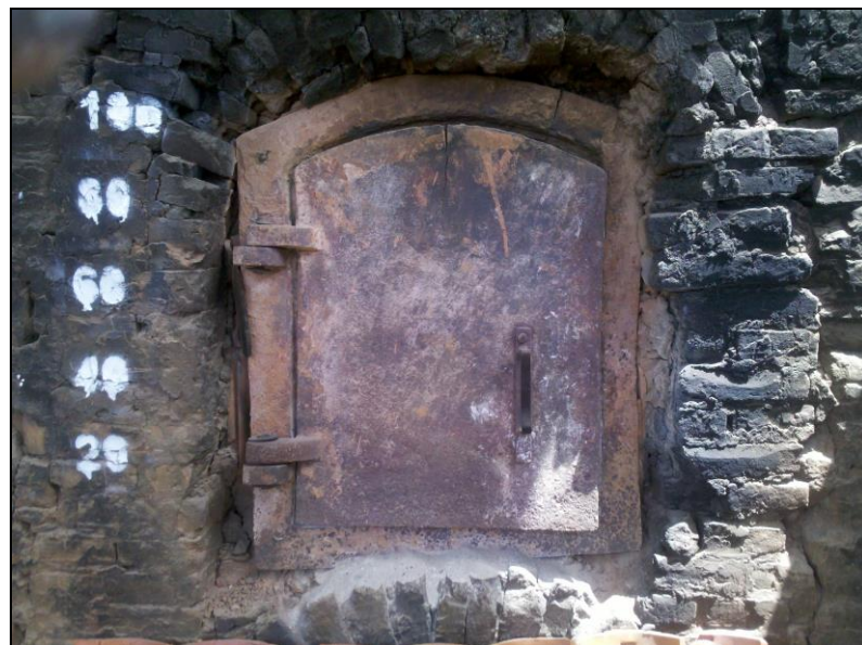
Figura 65 – Câmara de combustão.
