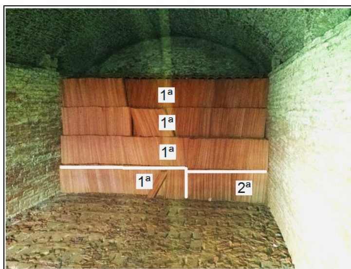
Figura 85 – Final do forno com o sistema microcontrolado inteligente e funcionários atingindo 87,94% de telhas de 1ª qualidade.
