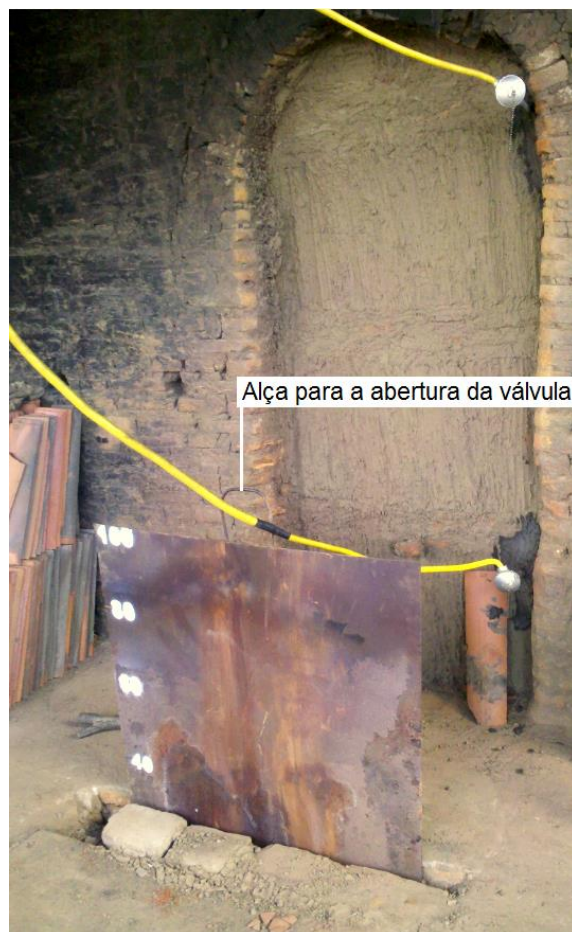
Figura 71 – Válvula do canal de exaustão.
