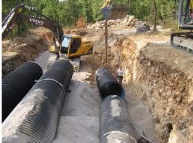
Figura 07 – Lançamento de dutos em valas, após preenchimento com colchão de areia.
